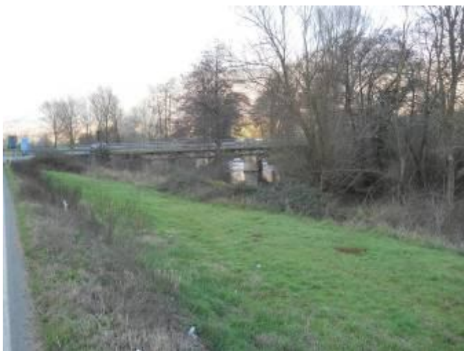
Il ponte attuale (Foto Carlo Loffredi 2012)
